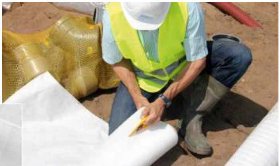
Zuschnitt des Filtervlieses mit dem Funke Filtervlieschneider
