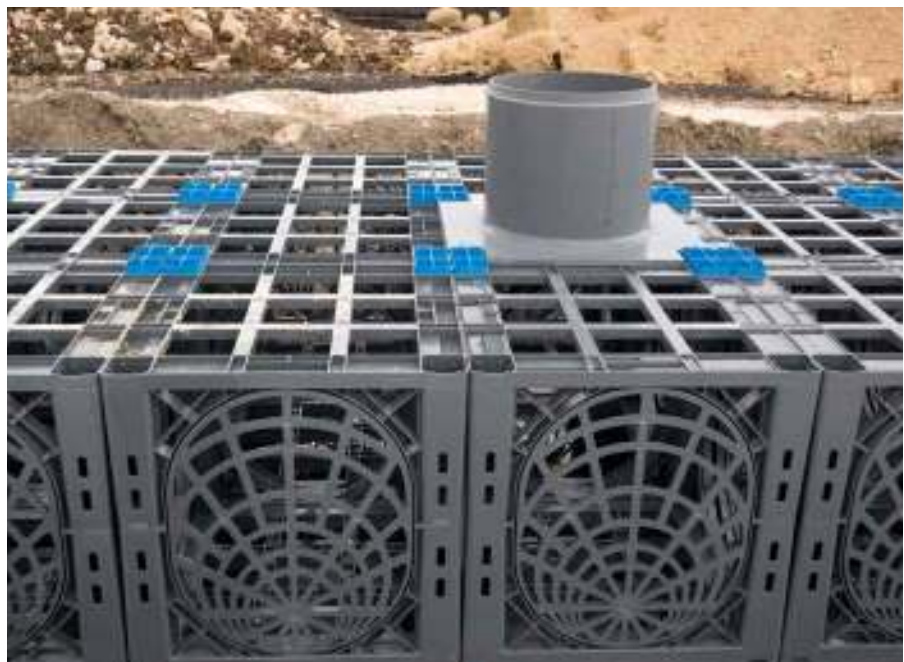
> Inspektionsblock mit Steigrohranschluss DN 400 zur Wartung
