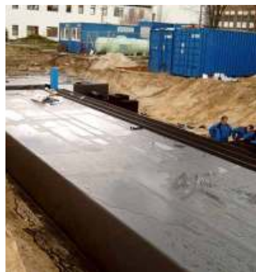
Dichtheitsprüfung an den Ecken
