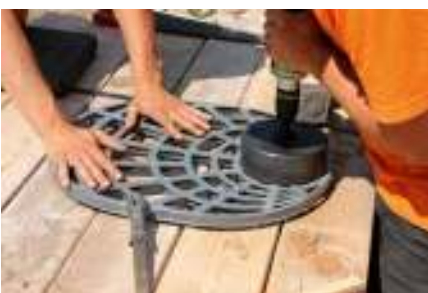
> Anschlussplatte mit Öffnung zum Durchführen von Zuleitungen mittels Stecksystem
